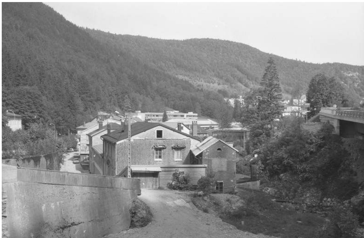
Vue d'ensemble depuis le sud (amont).
