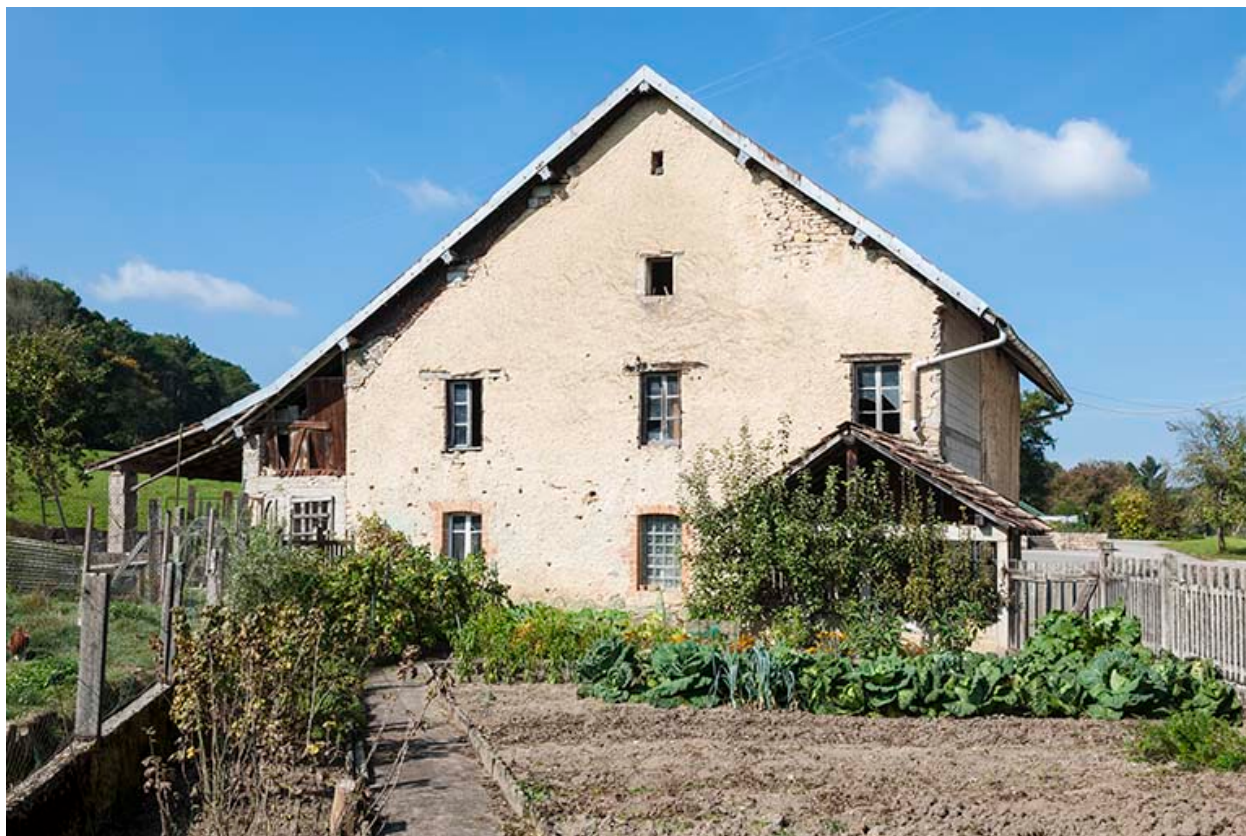
Vestige de la ferme, depuis le sud.
