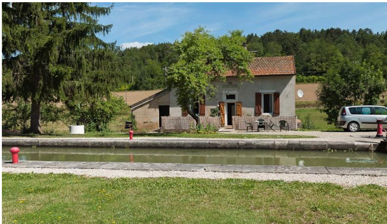
Vue de face de la maison éclusière.
