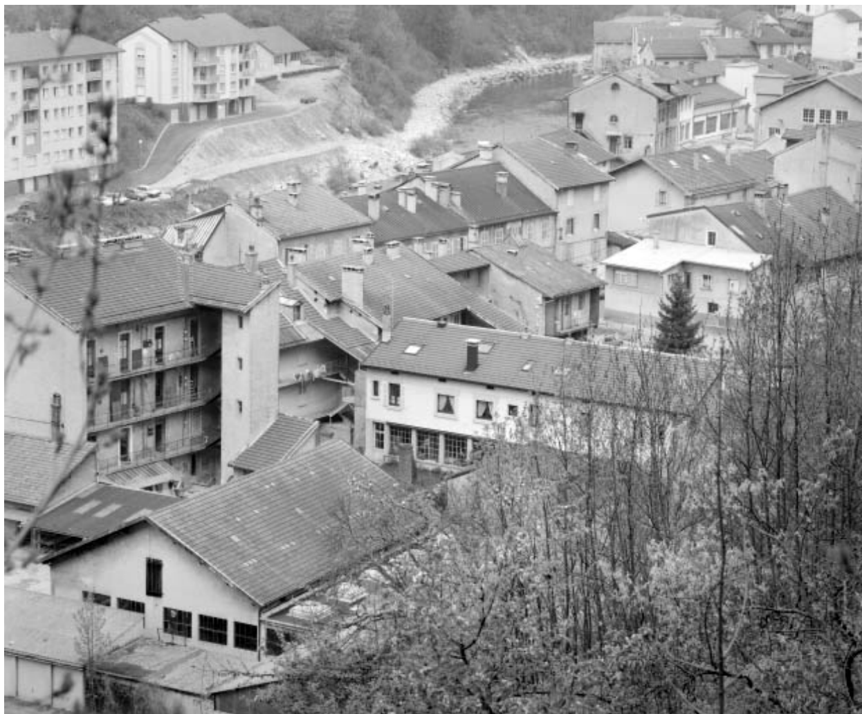
Vue d'ensemble plongeante depuis le sud-est.
