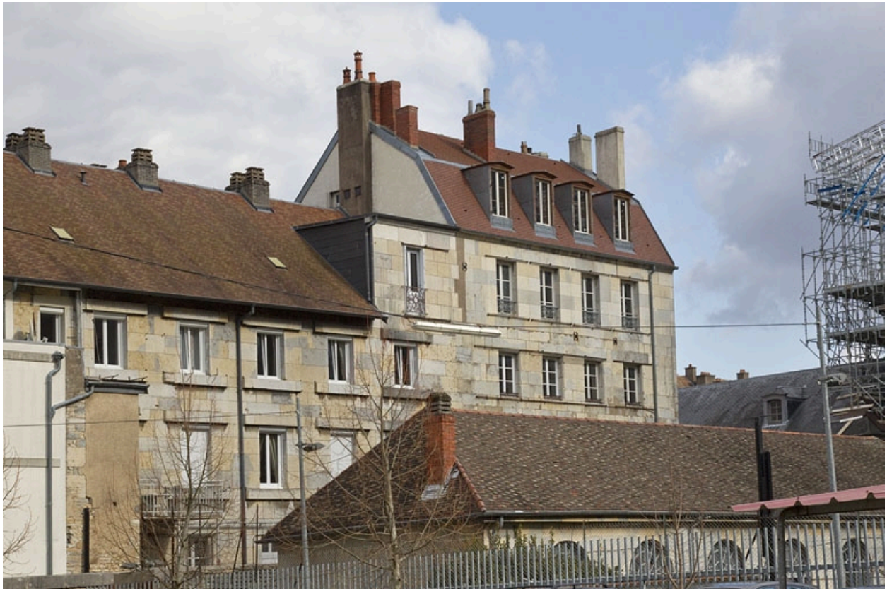
Vue éloignée de l'arrière de l'édifice.
