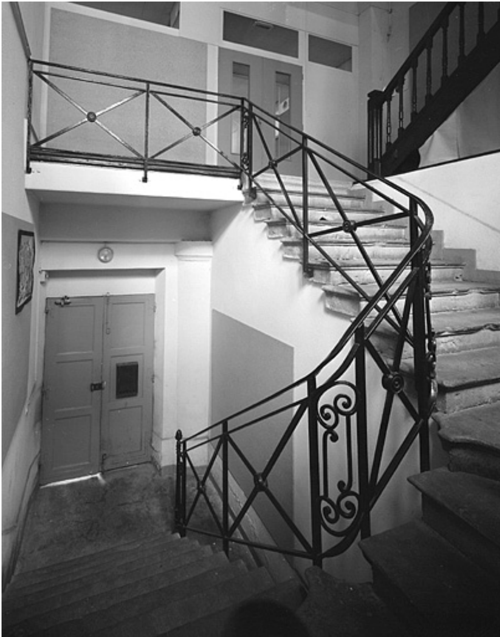
Escalier de l'aile ouest.
