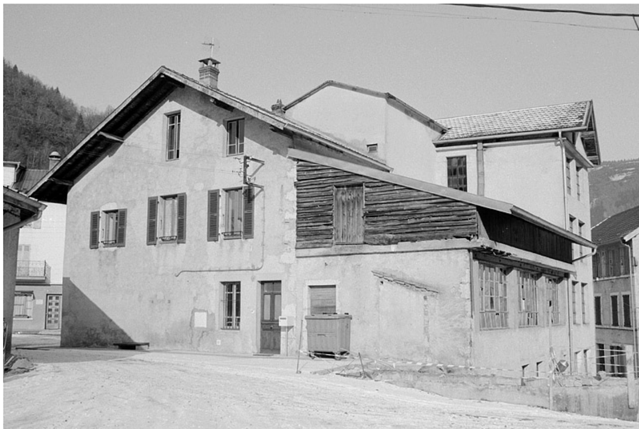
Minoterie, logements et atelier désaffecté.
