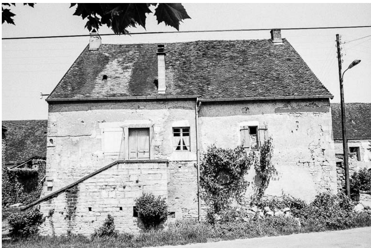
Fermes situées 322 rue d'Oisenans : façades antérieures.
