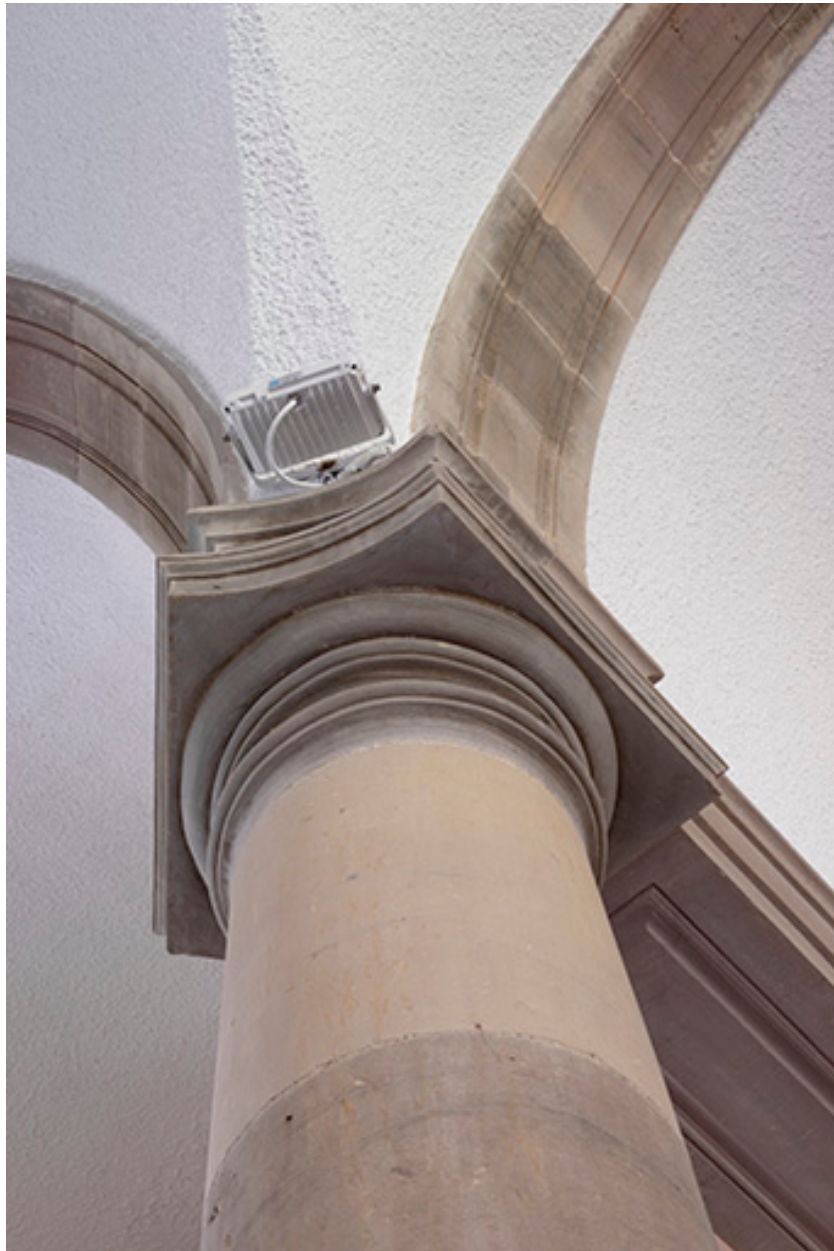
Salle du Bain gradué, détail des chapiteaux des colonnes.
