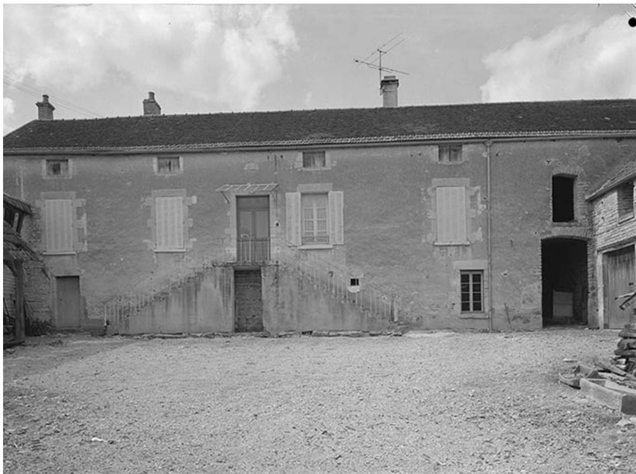
Logis et grange. Façades sur cour.
