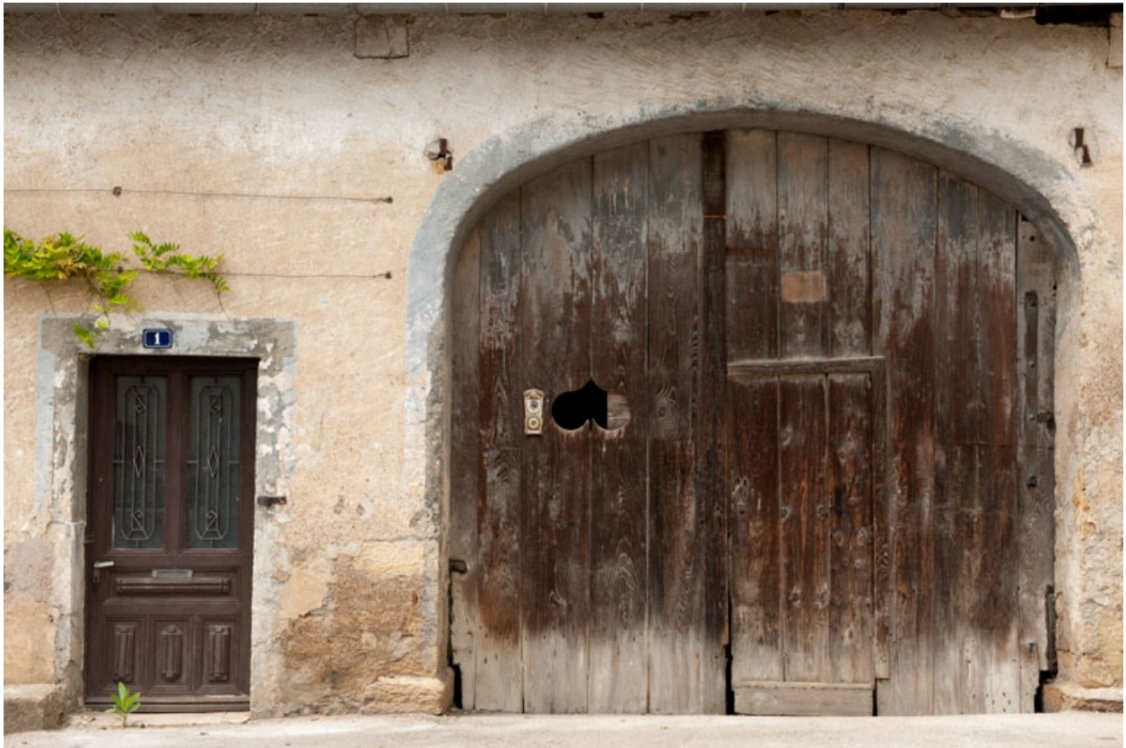
Détail de la façade, côté rue des Gratteris.
