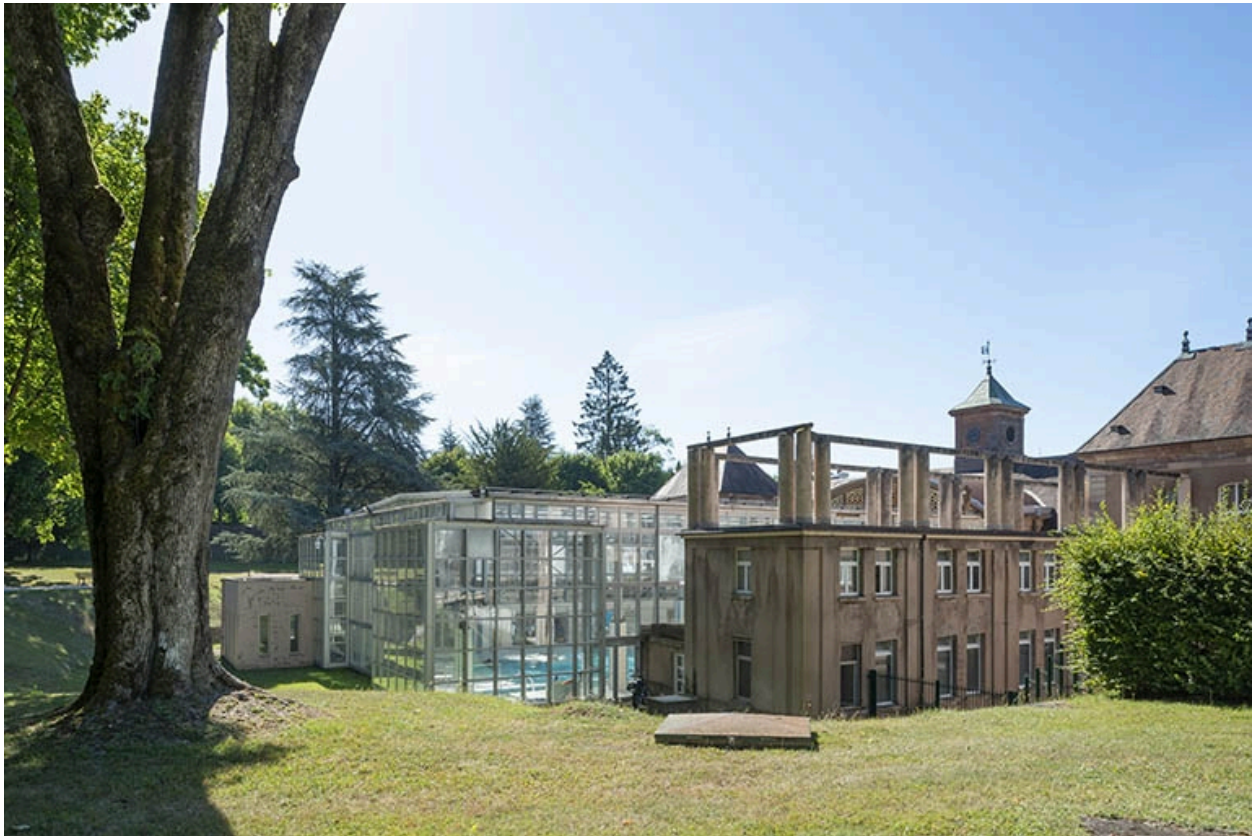
Vue en direction de l'établissement thermal.
