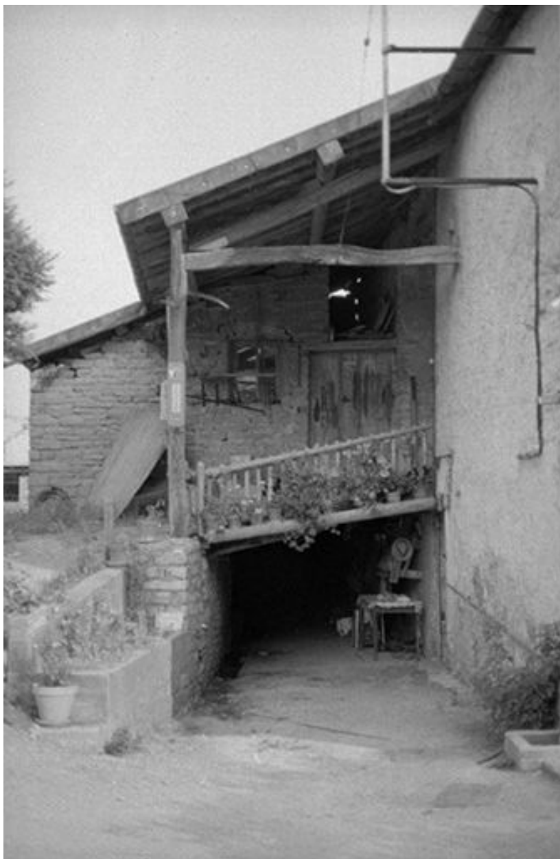
Façade latérale gauche : le pont de grange.
