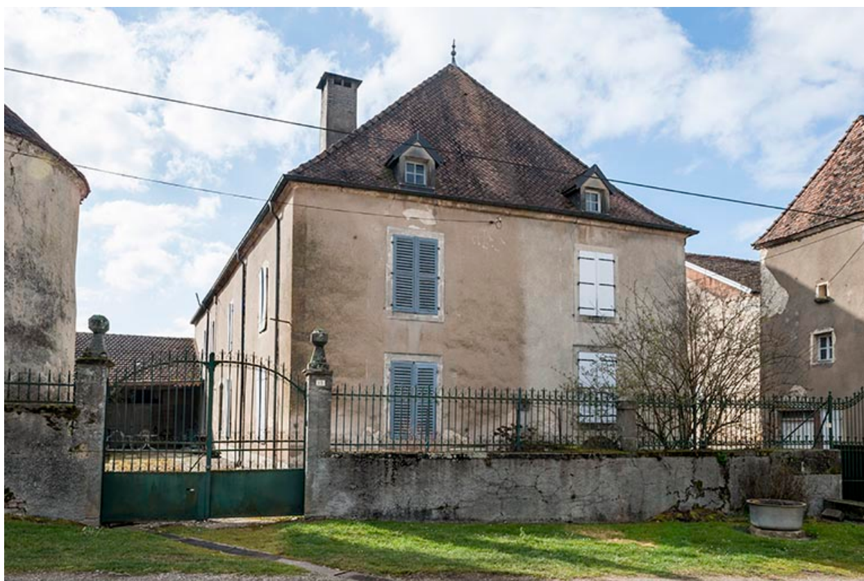
La demeure, façade nord.
