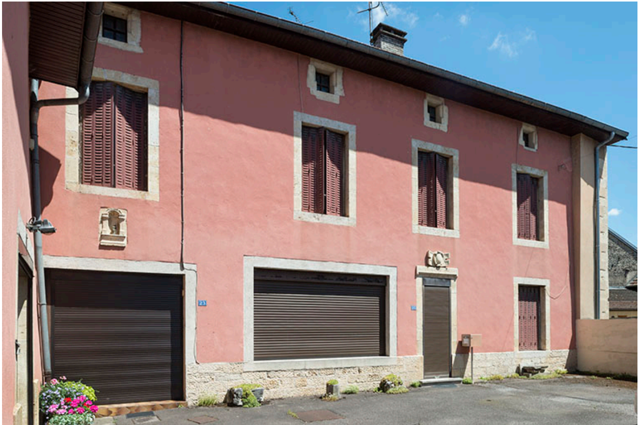
Élévation sur la cour.
