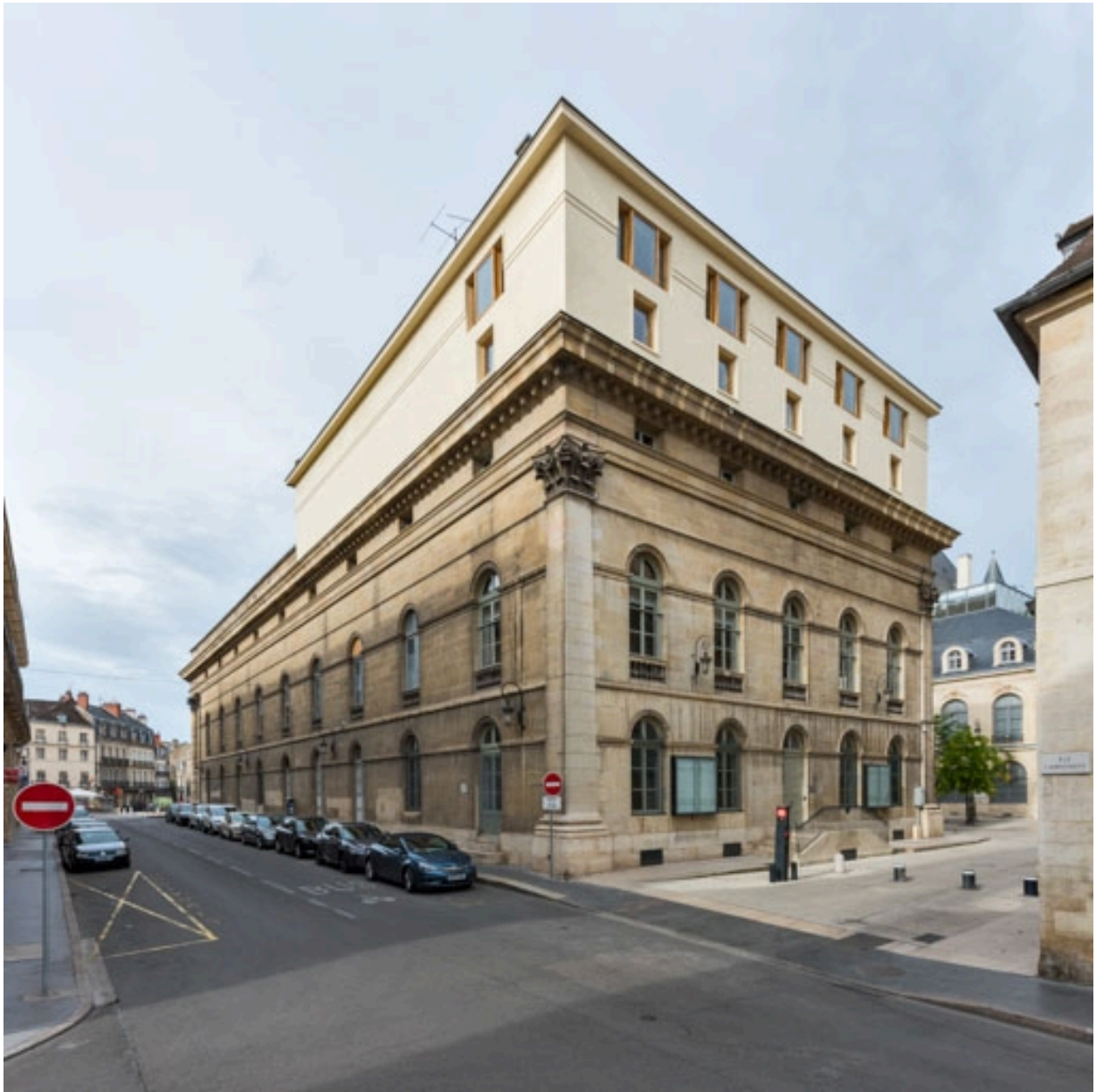
Façades postérieure et latérale droite.
