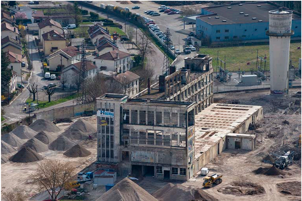
Etat début 2019. Vue plongeante sur le bâtiment conservé dite la "cathédrale".
