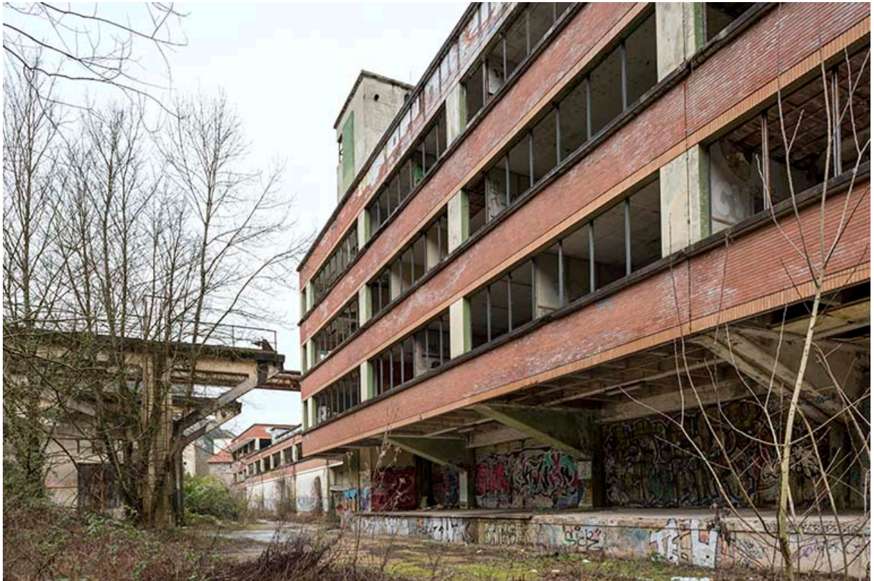
Etat en 2016. Usine A : façade sud de l'étirage tergal.
