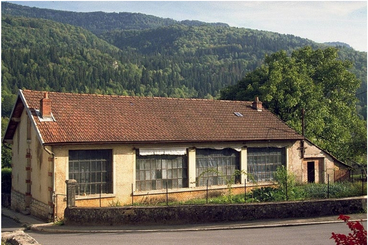
Façade latérale droite de l'atelier de fabrication.
