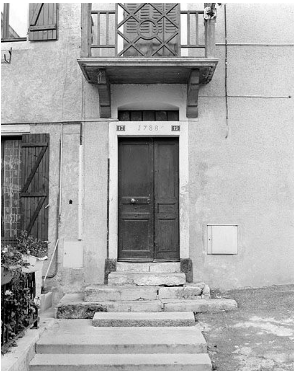
Maison avec atelier (18e siècle) aux n° 17 et 19 rue Wladimir Gagneur : porte d'entrée. Maison (AK 56, 57). L'imposte de la porte est coiffée d'un linteau délardé en arc segmentaire.
