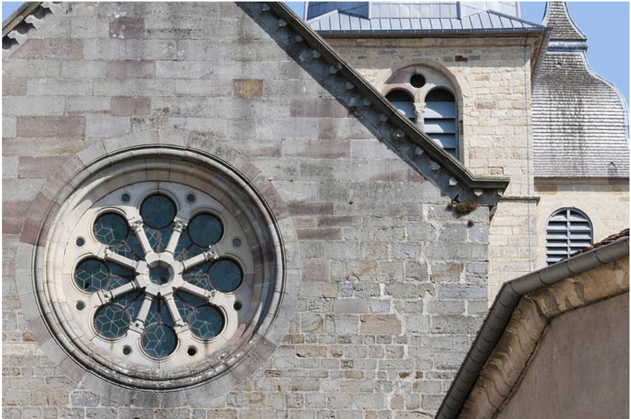
Façade antérieure, détail : l'oculus.
