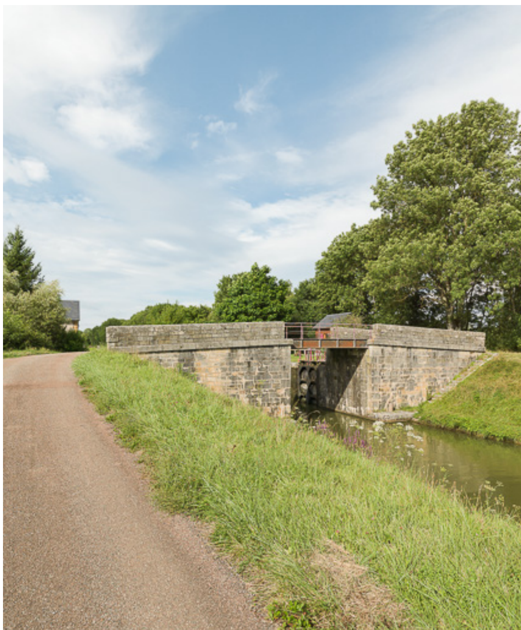
Vue d'ensemble du pont.
