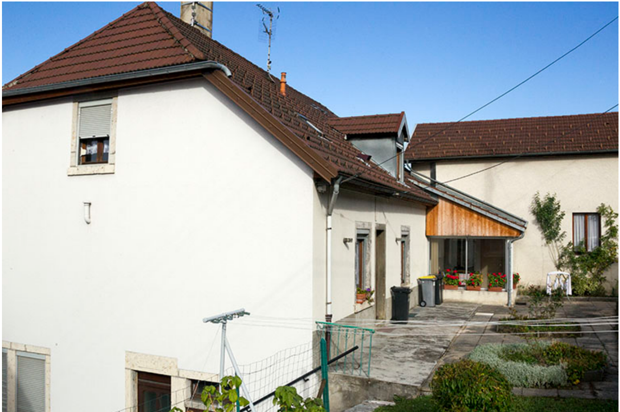
Façades postérieure et latérale droite.
