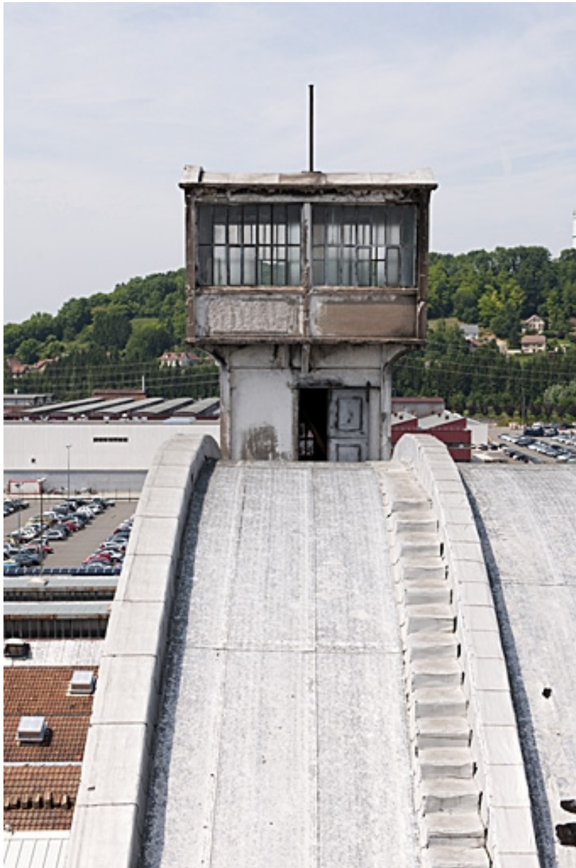
Entrepôt de stockage de véhicules (201) : guérite.
