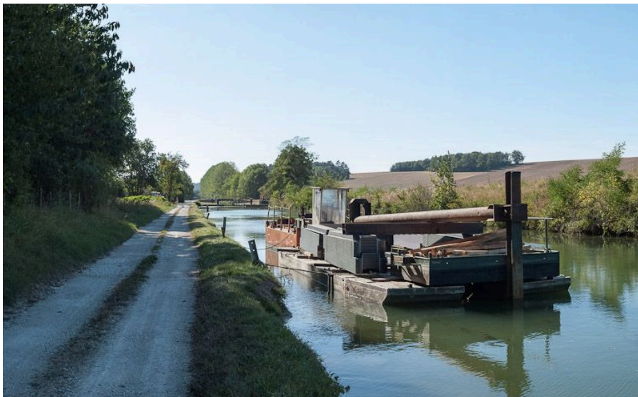
Barge de travaux sur palplanches à Ancy-le-Franc.
