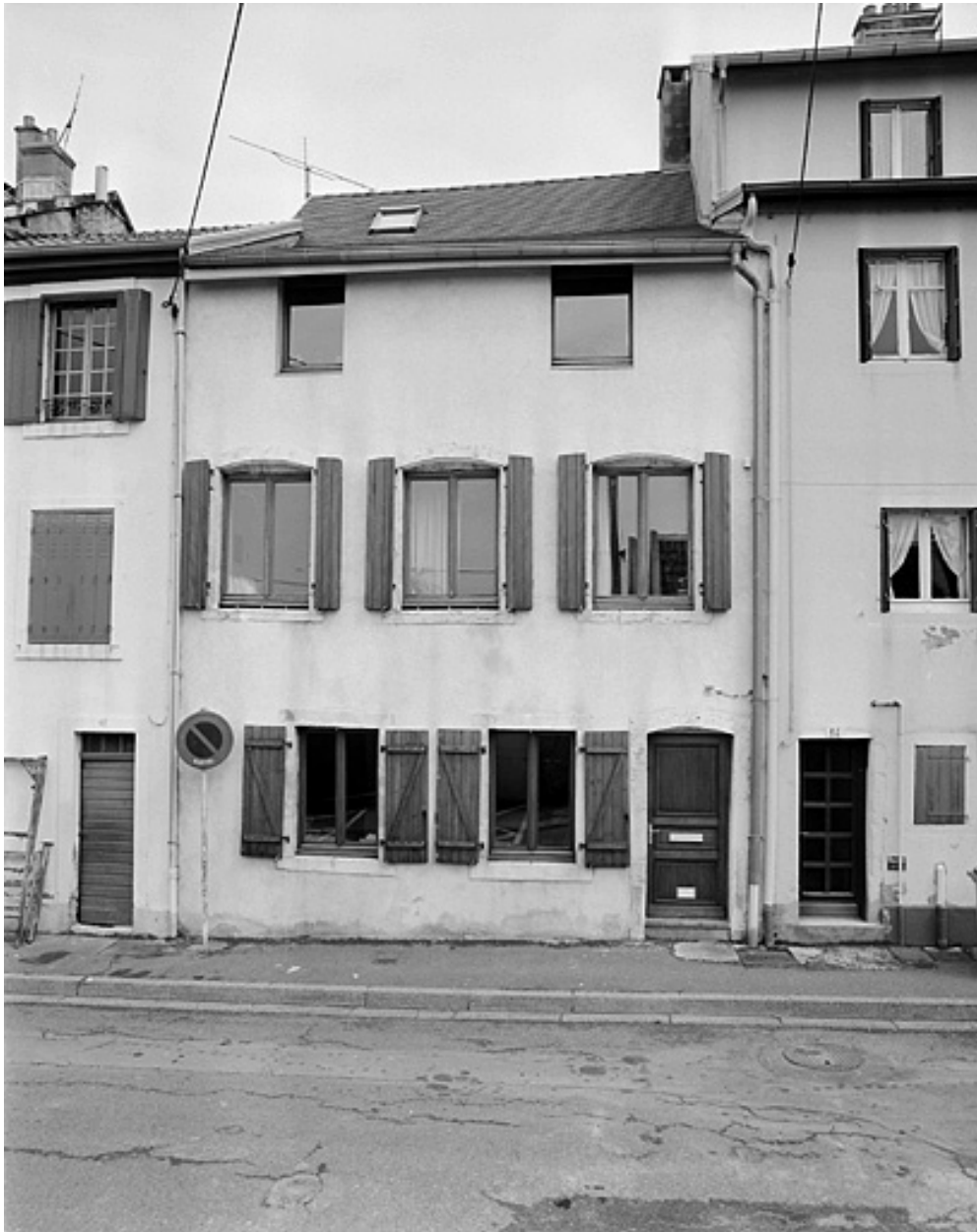
Maison 16, rue des Potiers. 18e siècle.
