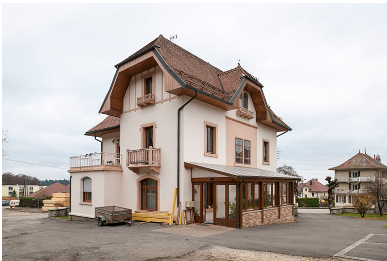
Logement patronal : façades sud et est.
