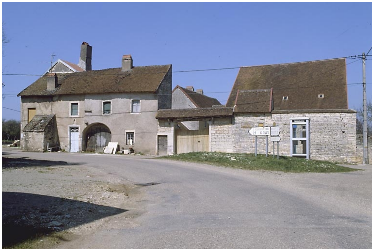
Vue d'ensemble après destruction du bâtiment agricole.
