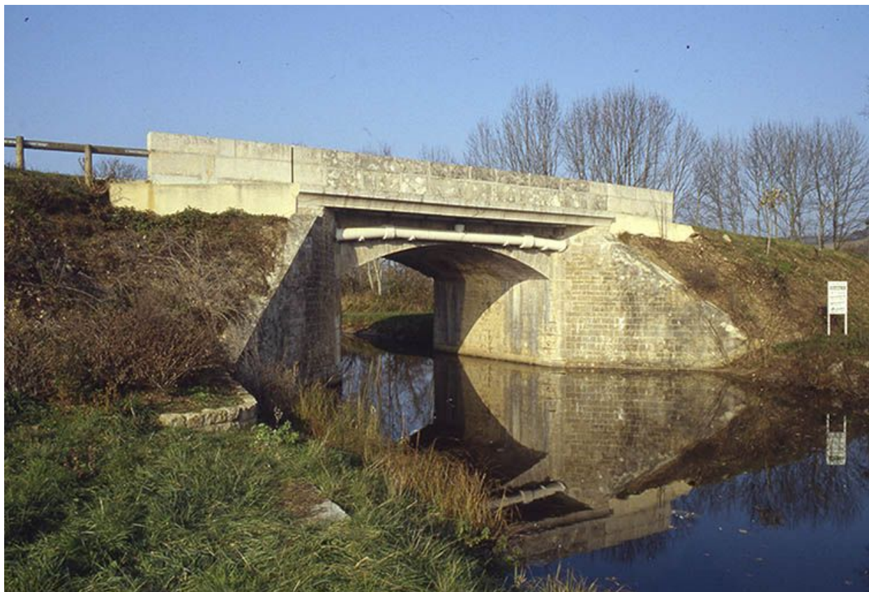
Vue d'ensemble prise de l'aval.
