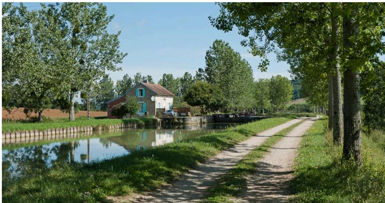
Vue du site d'écluse depuis l'amont.
