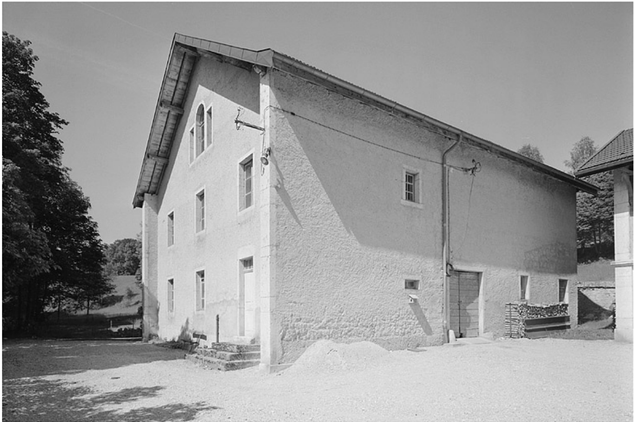
Façade antérieure et face droite de la ferme.
