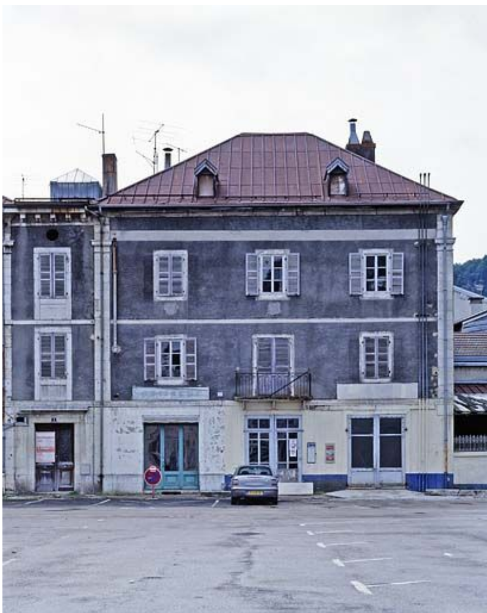
Le corps de bâtiment occidental.
