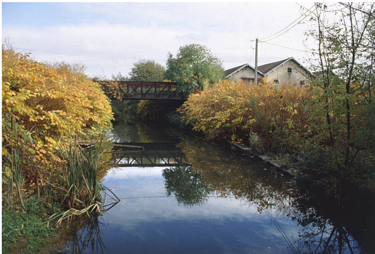
Canal d'amenée depuis l'aval.
