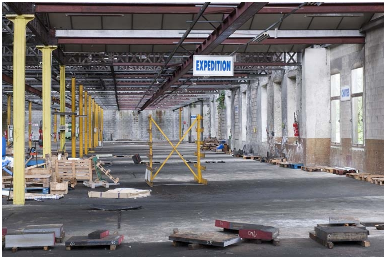
Travée d'un atelier de fabrication.
