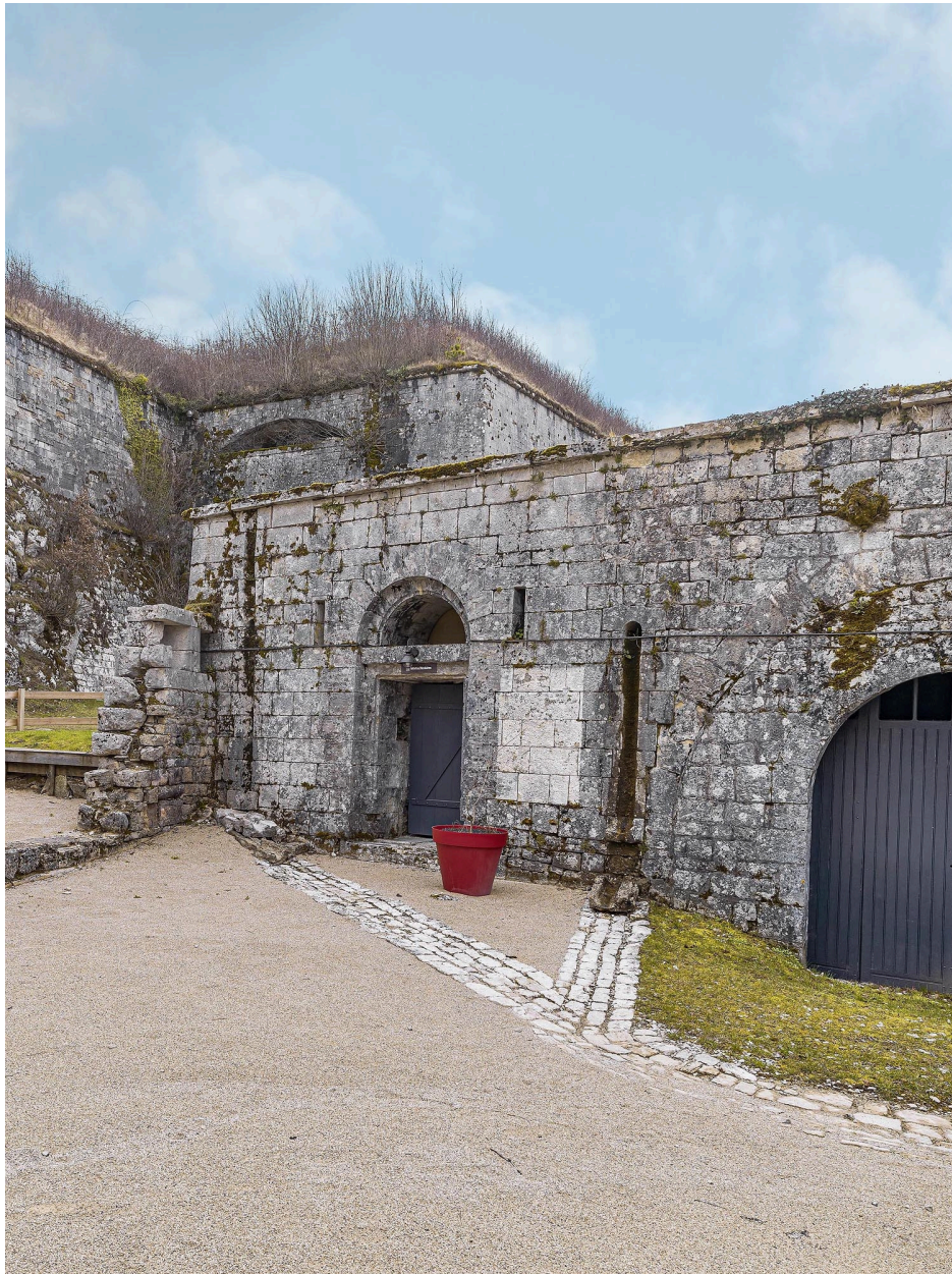
Entrées des casemates du flanc gauche.
