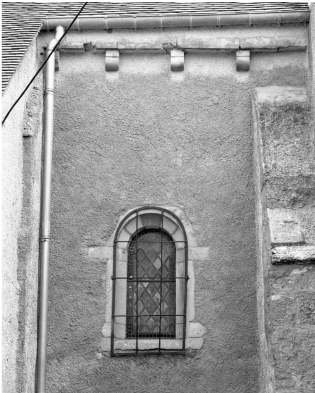
Elévation gauche, fenêtre et corniche du choeur
