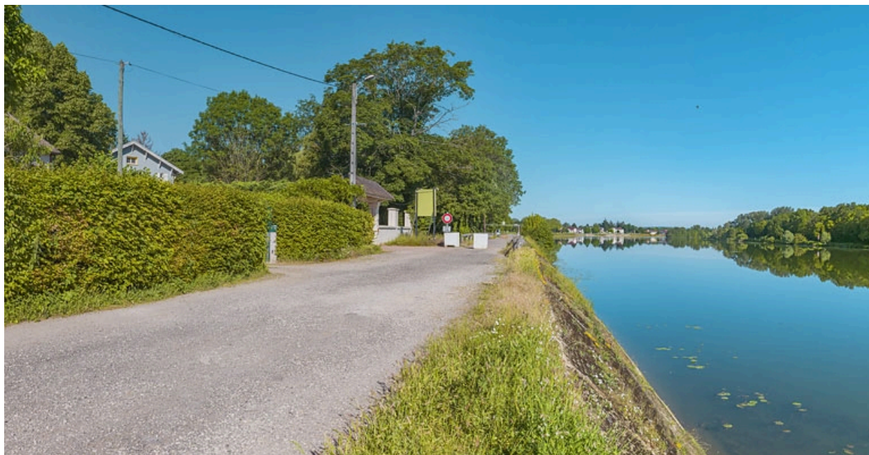
Extrémité aval du quai avec le pont sur la Roie de Droux.
