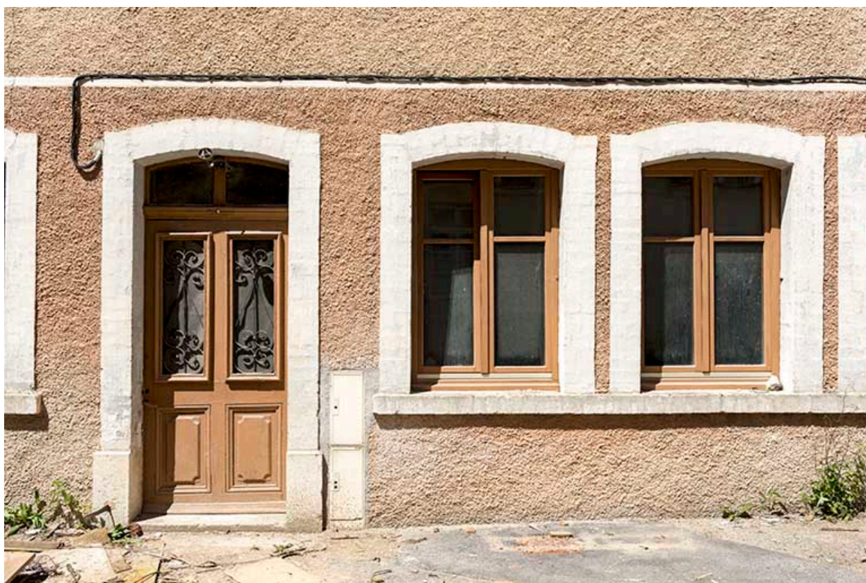
Façade postérieure : porte et fenêtres multiples.
