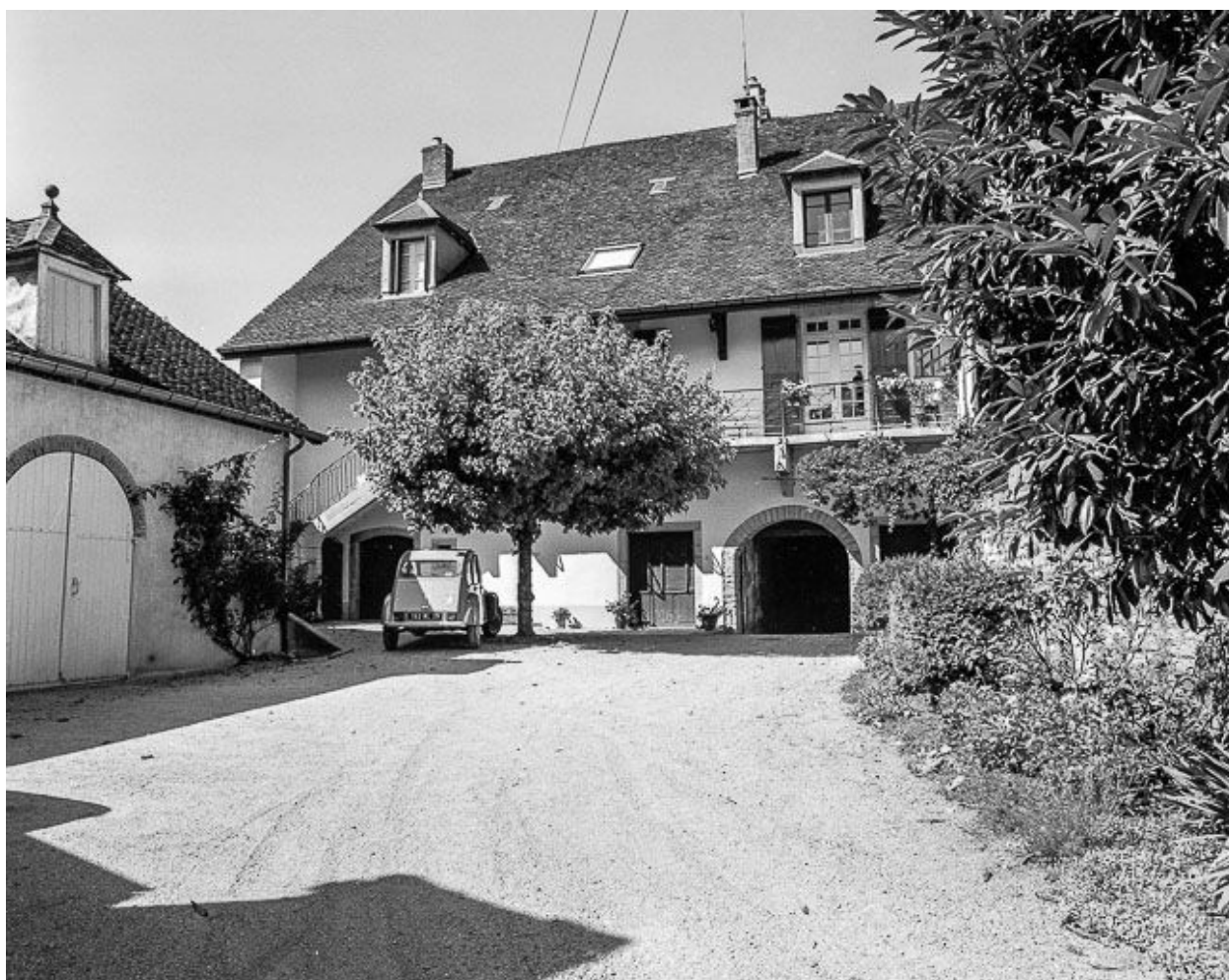
Maison de vigneron située route du Sud-Revermont.
