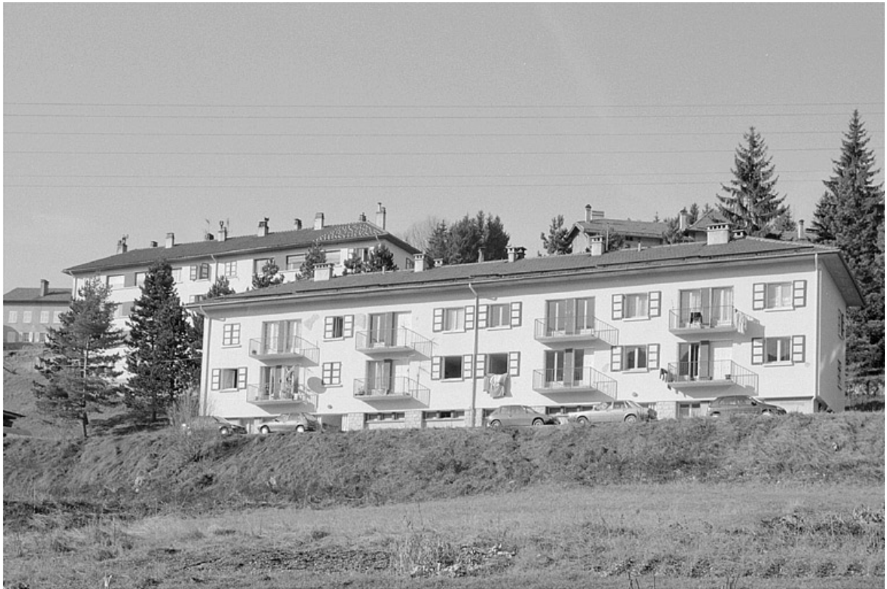
Logement d'ouvriers, depuis le sud-est.
