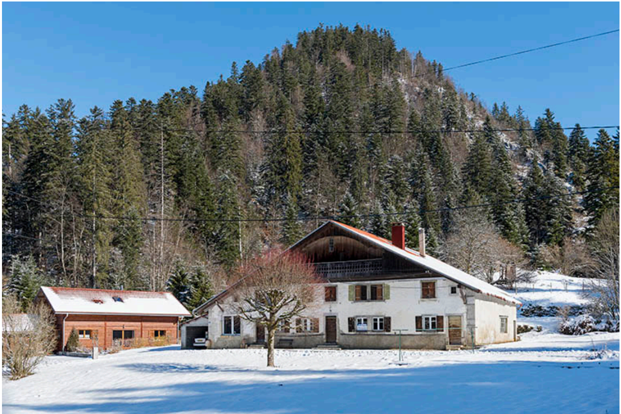
Vue d'ensemble, depuis l'ouest, en hiver.
