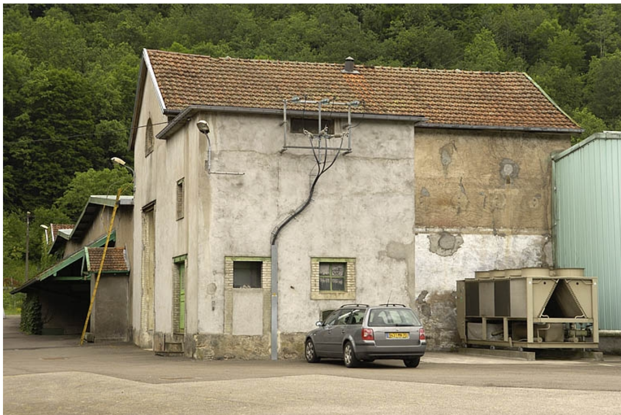
Transformateur et ancienne chaufferie.
