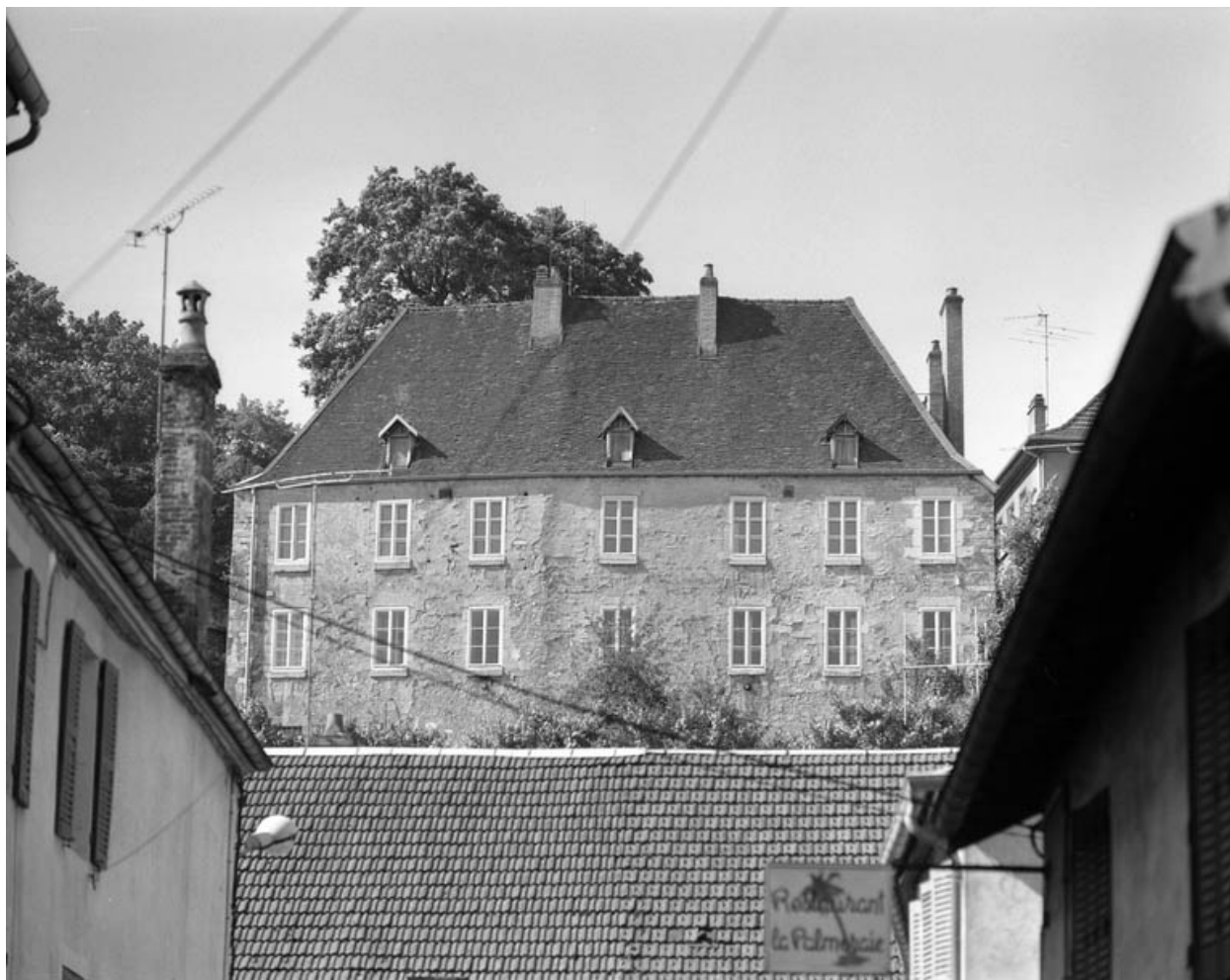
Façade postérieure, de face.
