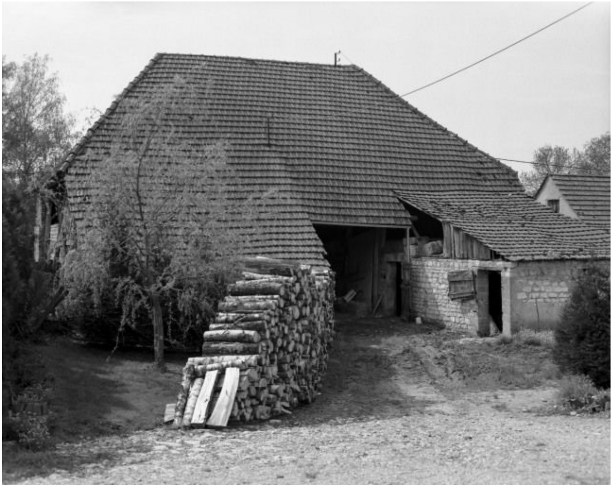
Grange de la ferme (cad. 1984, sect. AB, parc.149).
