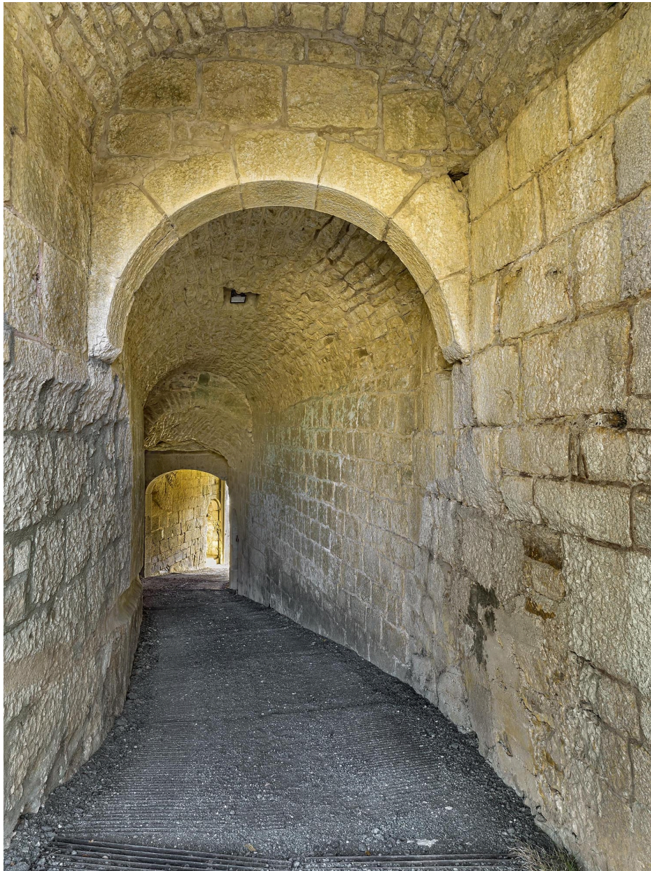
Passage intérieur du cavalier.
