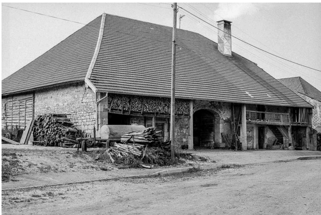
Ferme, cadastrée 1938 F 62 : façade antérieure.
