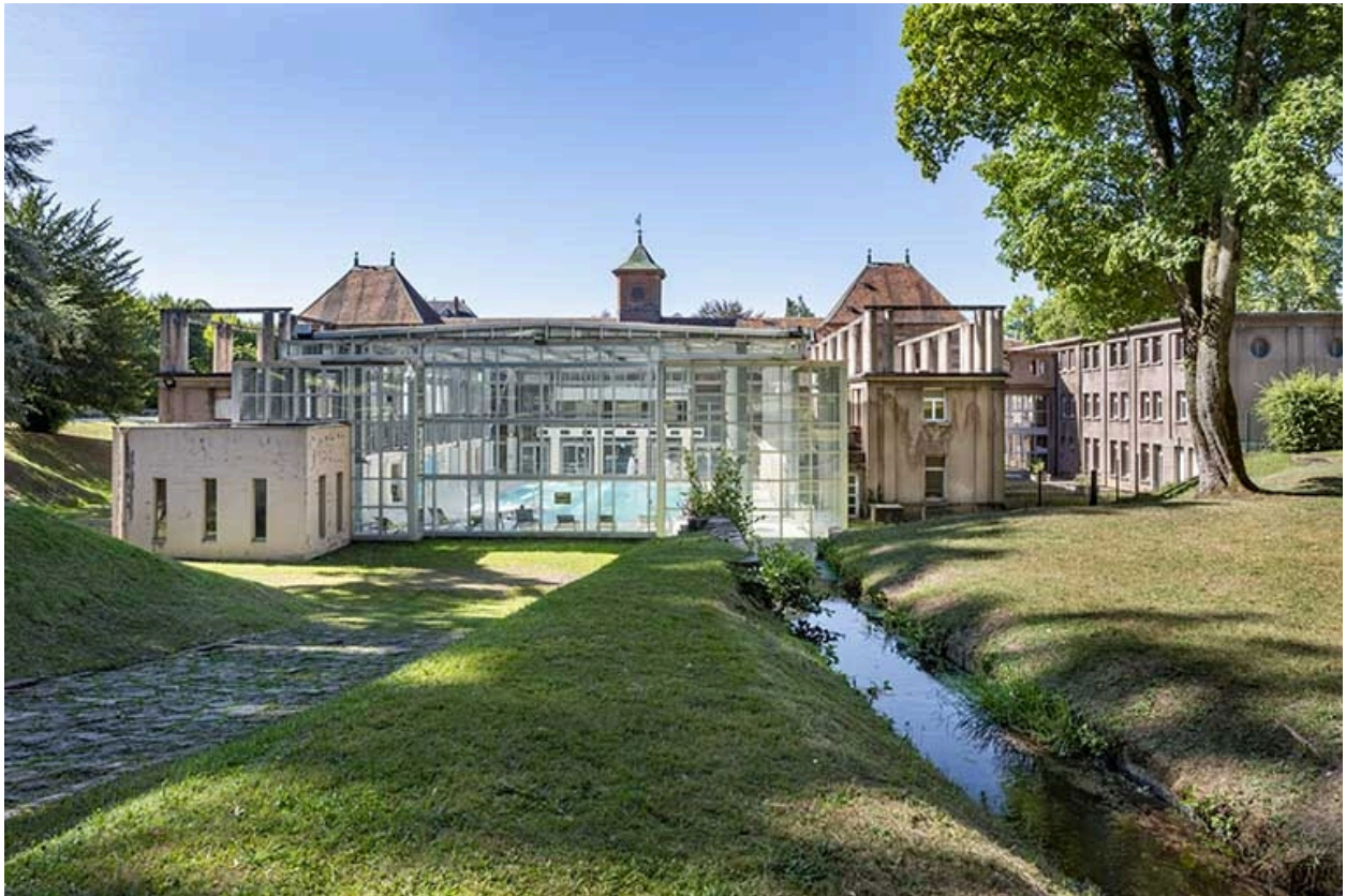
Vue en direction de l'établissement thermal.
