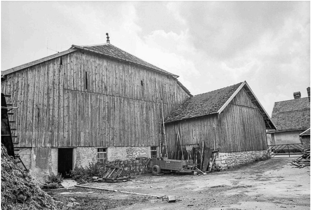
Pignon postérieur de la partie agricole.
