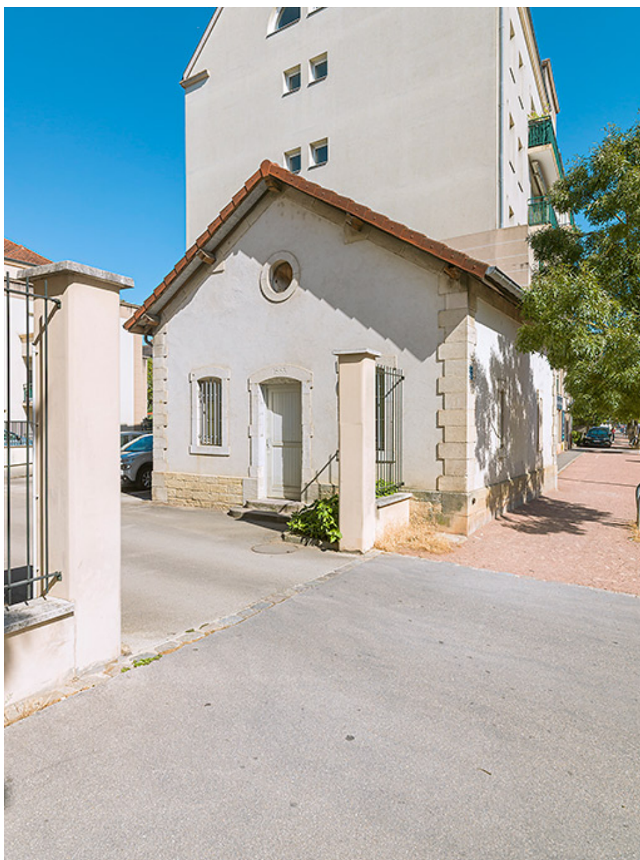
Corps de garde du magasin à poudre, rue d'Auxonne.
