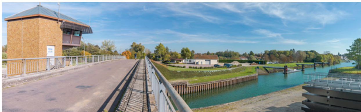
Pont sur le site d'écluse de Seurre.
